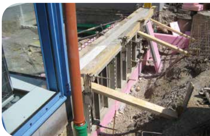
Arbeiten am Fundament
